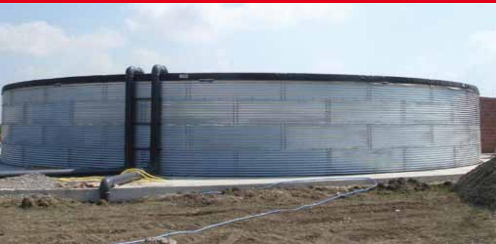
Fot. 2. Zbiornik z blachy ocynkowanej do gromadzenia wody
